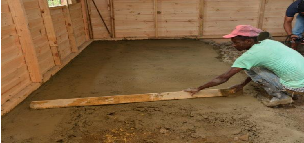
Cambio de Piso de Tierra por Piso de Cemento
